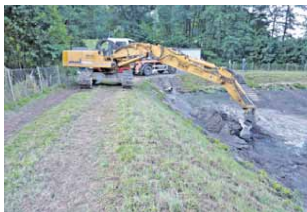
Ausgebaggert: der Schlamm wurde aus dem Becken entfernt
