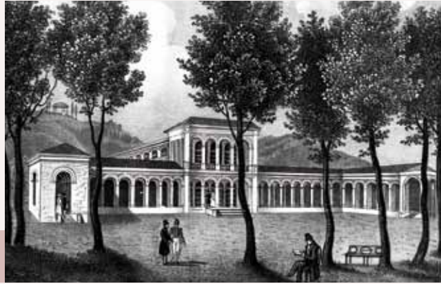
Arkadenbau 1838 - noch als Dreiflügelanlage
