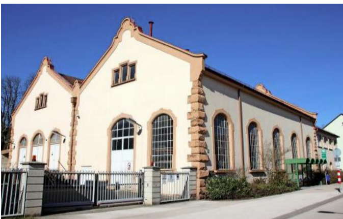
1905 Das städtische E-Werk entstand. Ab Juni waren in Bad Kissingen alle Straßen elektrisch beleuchtet. Zum Vergleich: Die viermal größere Industriestadt Schweinfurt bekam ein Jahr später elektrische Straßenlampen.
