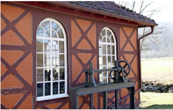
1883 Mit zwei doppelt wirkenden Pumpenkolben beförderte die Hauspumpe an der Unteren Saline das Wasser aus dem Runden Brunnen zum Kurhausbad sowie zu privaten Kurhäusern in der Stadt.
