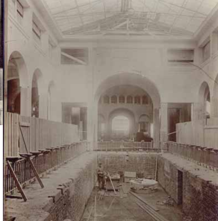
Die Brunnenhalle im Bau mit Blick auf das Mittelschiff
