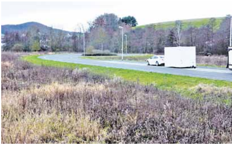
Fertiggestellt: die neue Wendeschleife
