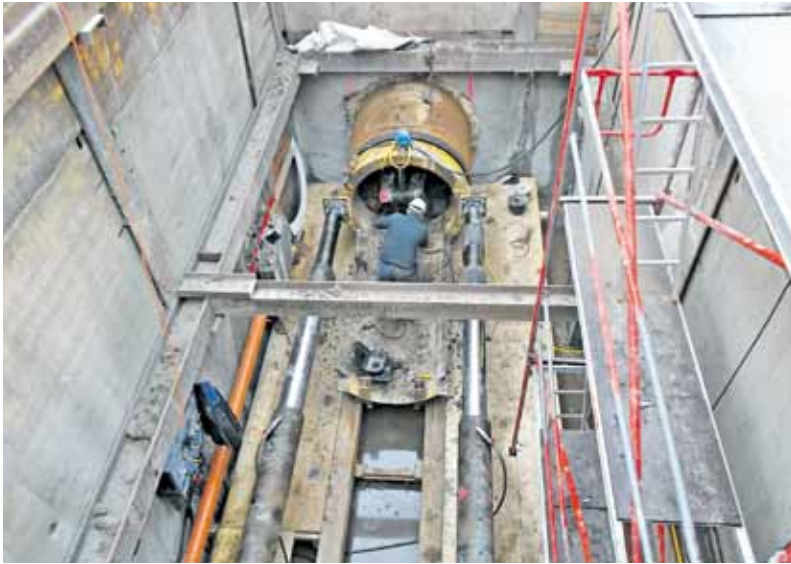
Start- und Pressgrube
