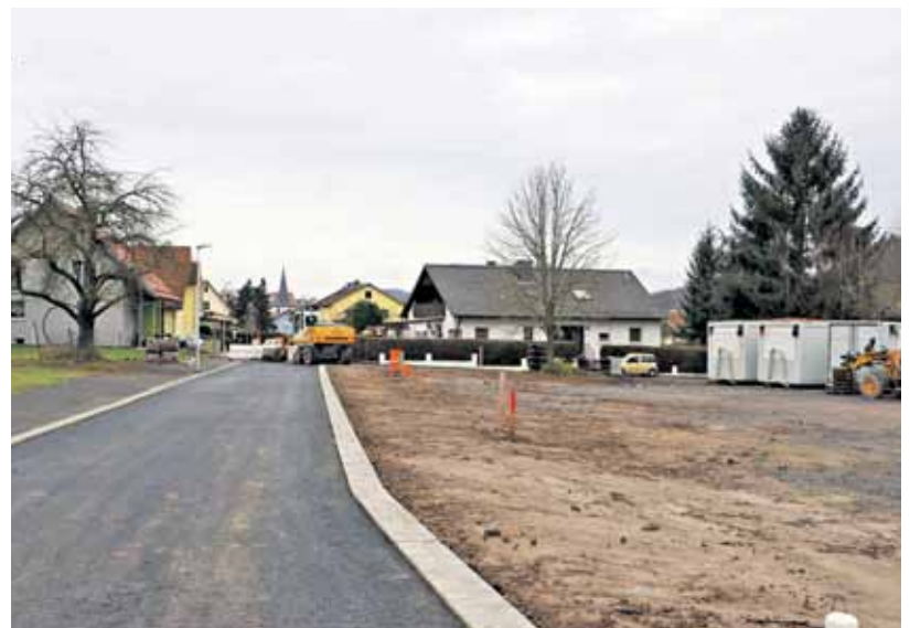
Die Erschließungsarbeiten am Baugebiet „Gründlein“ sind kurz vor der Fertigstellung
