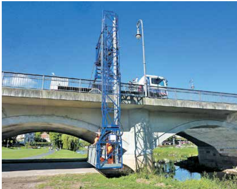
Nur mit einem Untersichtgerät war die Überprüfung der Ludwigsbrücke möglich. Denn auch schwer zugängliche Teile wie Brückengeländer, Fundamente, Widerlager, Auflager sowie der Brückenkörper samt Gewölbe mussten eingehend untersucht werden.
