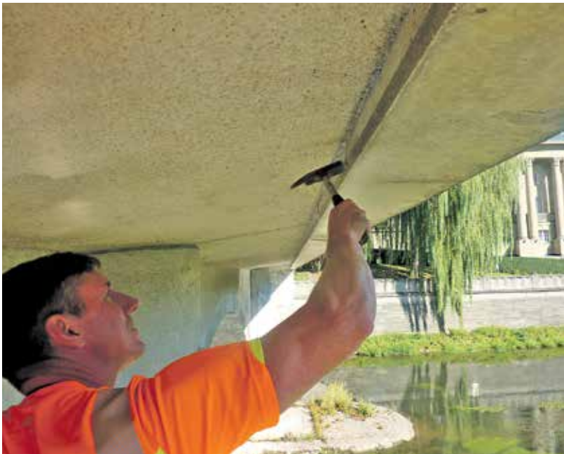
Der Brückenspecht klopft die zu prüfenden Stellen ab und identifiziert so kritische Hohlräume.
