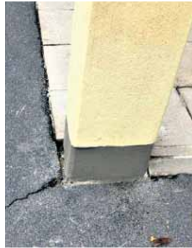
Buswartehalle Seehofstraße/Westring vorher und nachher: Schäden an der Stütze
