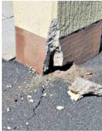
Buswartehalle Seehofstraße/Westring vorher und nachher: Schäden an der Stütze
