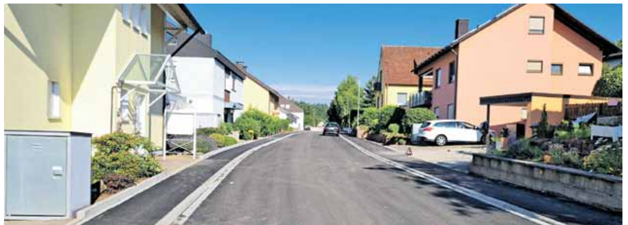
Technisch und optisch top: die rundum erneuerte Straße
