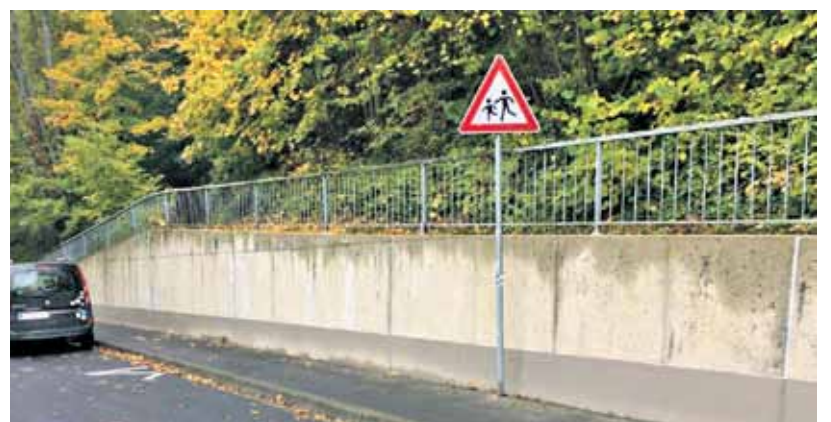
Stützmauer Schützenstraße vorher und nachher: Offene Fugen und Betonabplatzungen wurden ausgebessert
