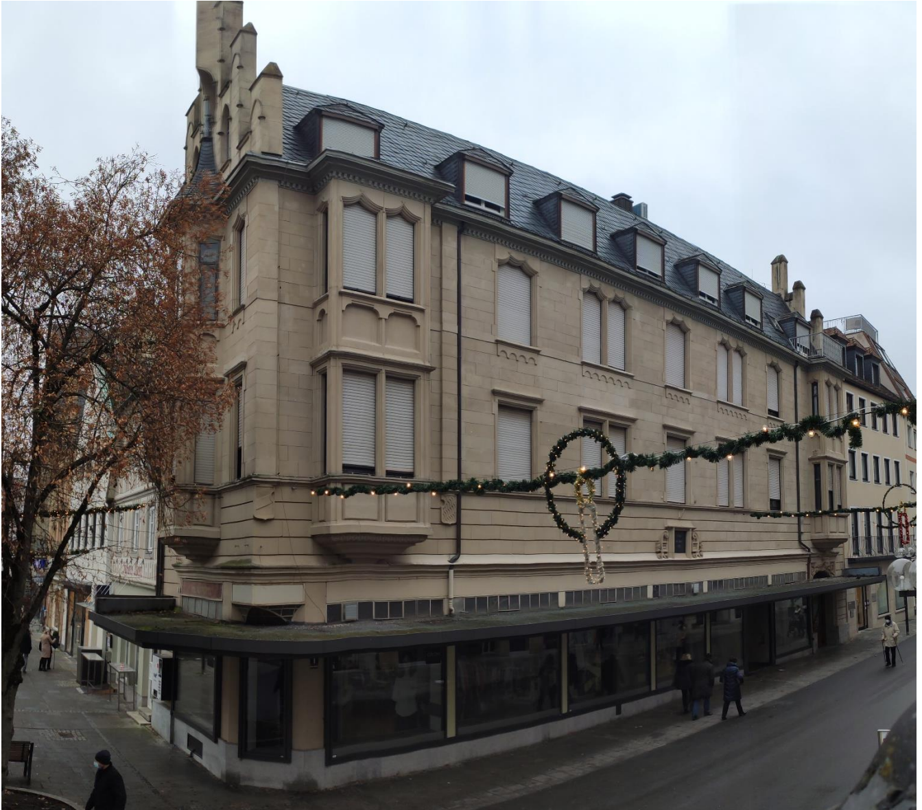
Ehemaliges Kaufhaus der Gebrüder Liebmann © Foto: Rolf Dotzauer
