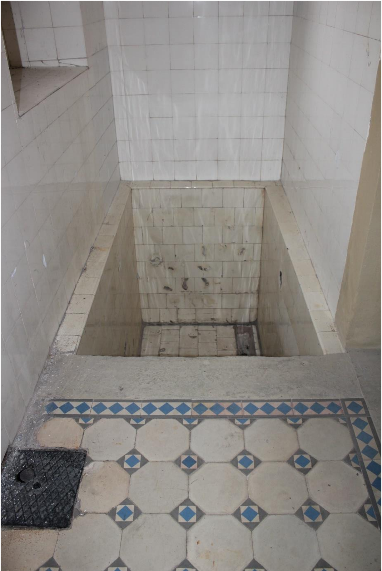
Die ehemalige Mikwe im Keller des Jüdischen Gemeindehauses © Foto: Marcel Bühner
