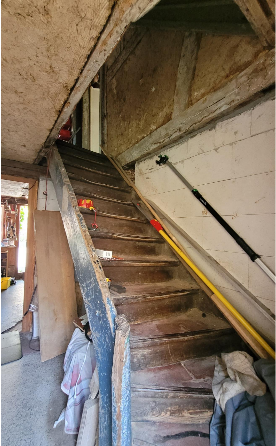
Treppe im Haus David Löw Stahls und Meyer Loeb Kissingers, 2023 © Foto: Elizabeth Levy
