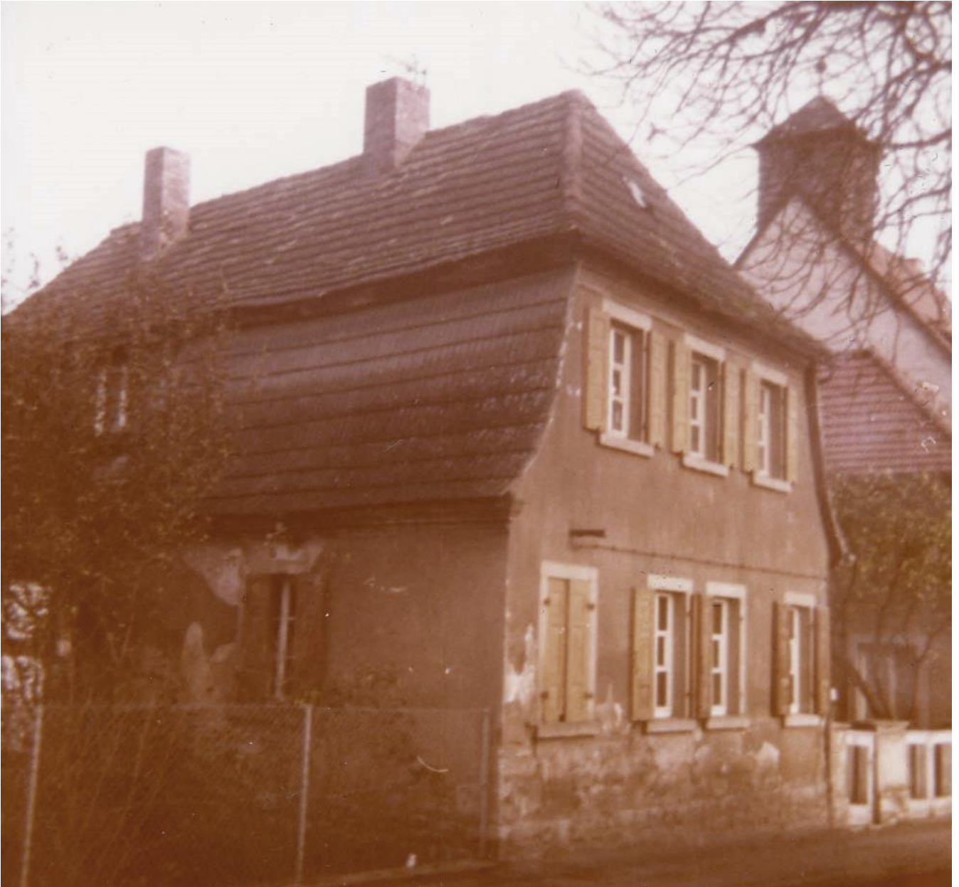
Das Haus der Steinbergers in der Bachstraße 3 vor dem Abriss © Privatbesitz
