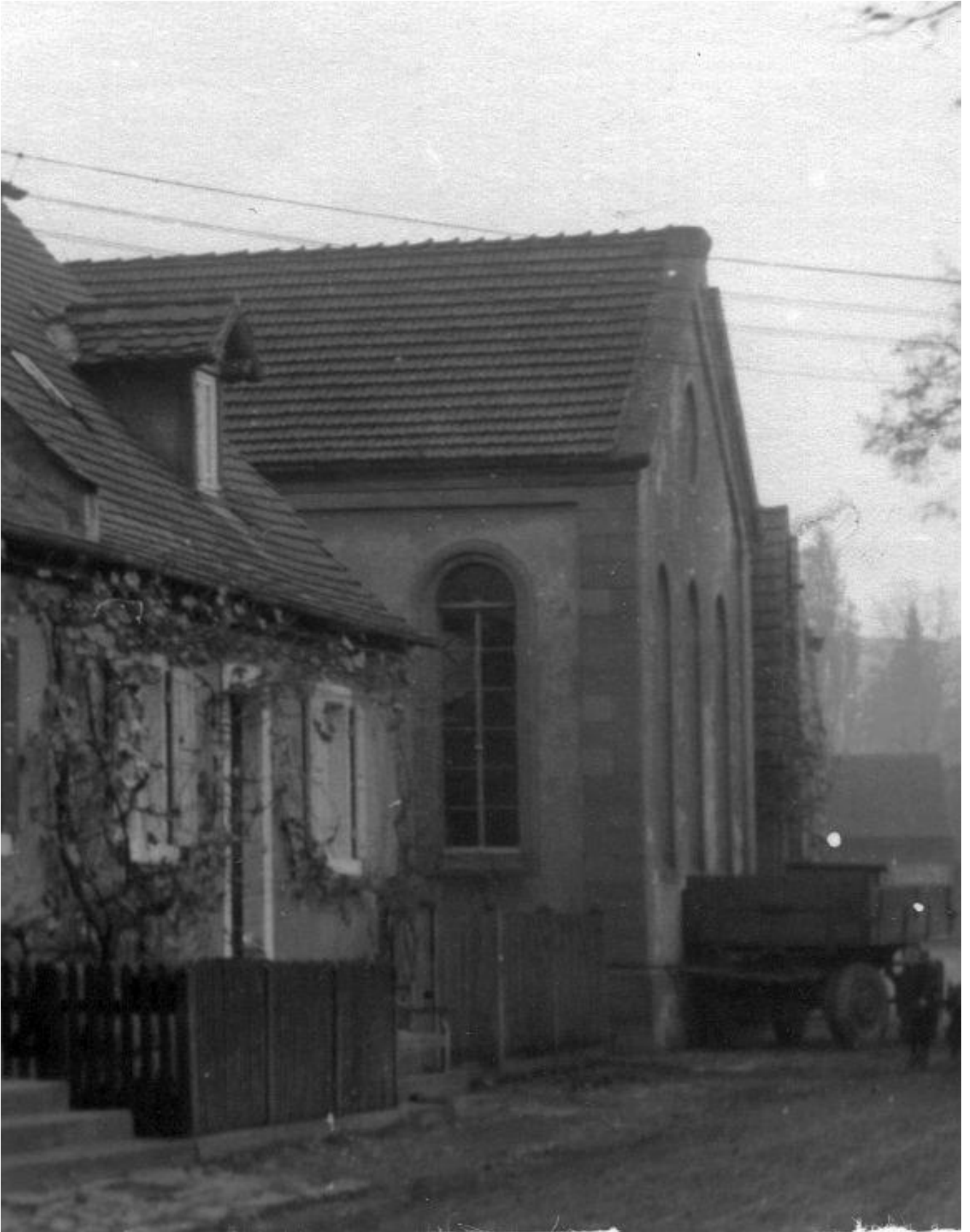
Das Synagogengebäude in Schonungen vor dem Umbau © Gemeinde Schonungen (Hrsg.): Schonungen. Bilder aus vergangenen Tagen, Schonungen 1987
