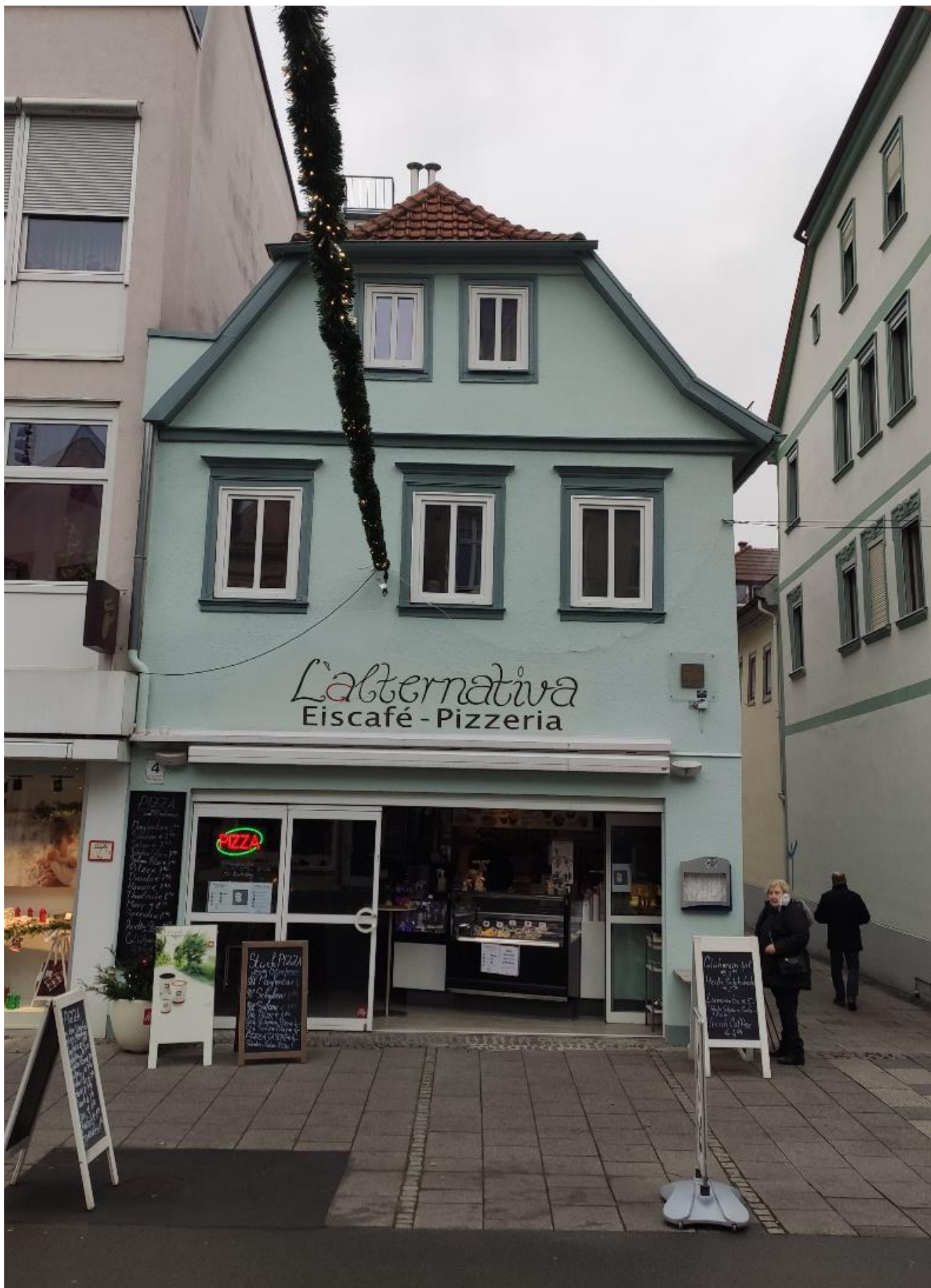
Ehemaliges Geschäftshaus von Solms und Hartwig Heymann am Marktplatz © Foto: Rolf Dotzauer
