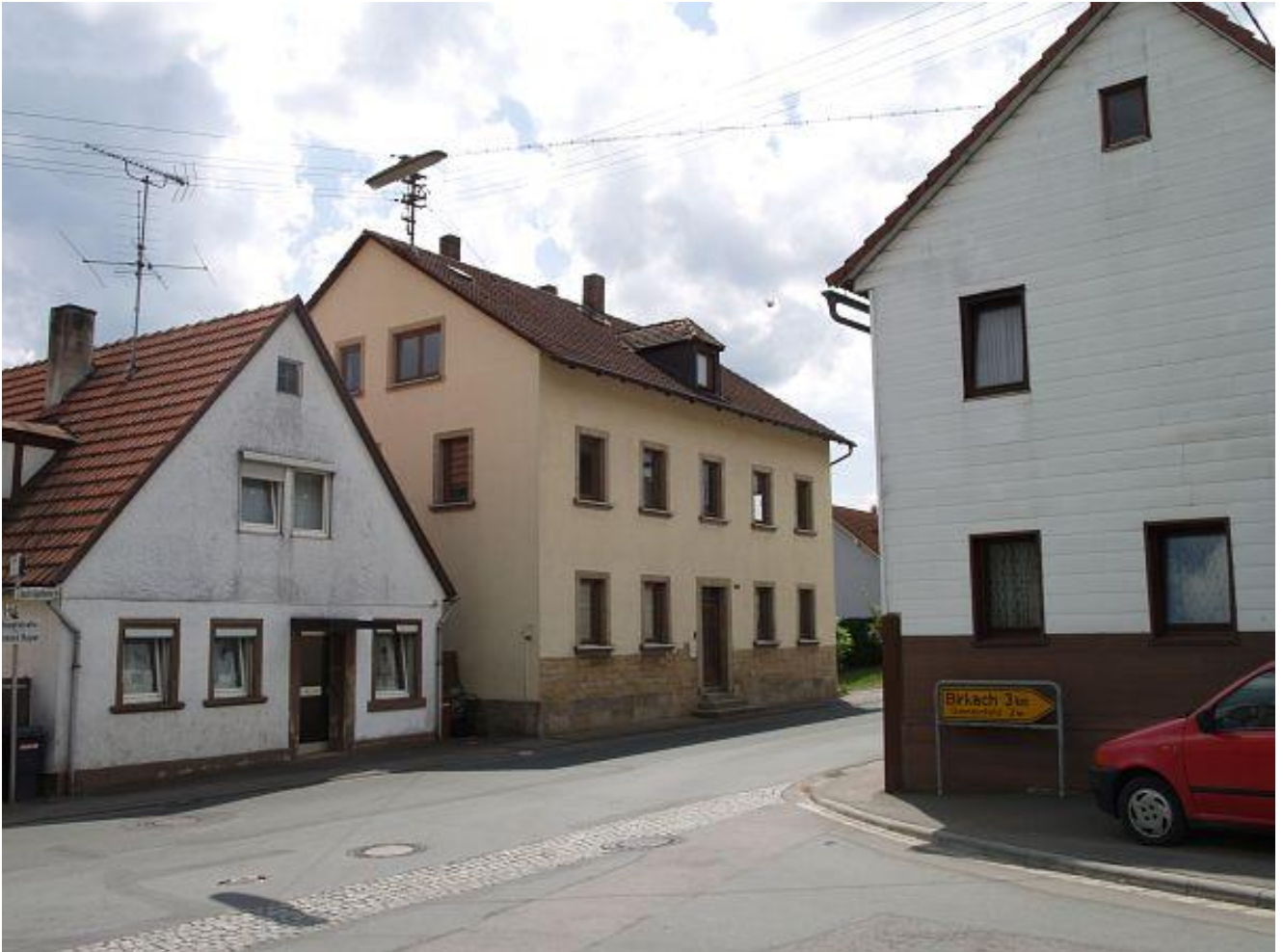
Das ehemalige Ess- und Wohngebäude der Talmud-Thora-Schule in der Hauptstraße 109 in Burgpreppach, 2007 © Foto: Dr. Joachim Hahn
