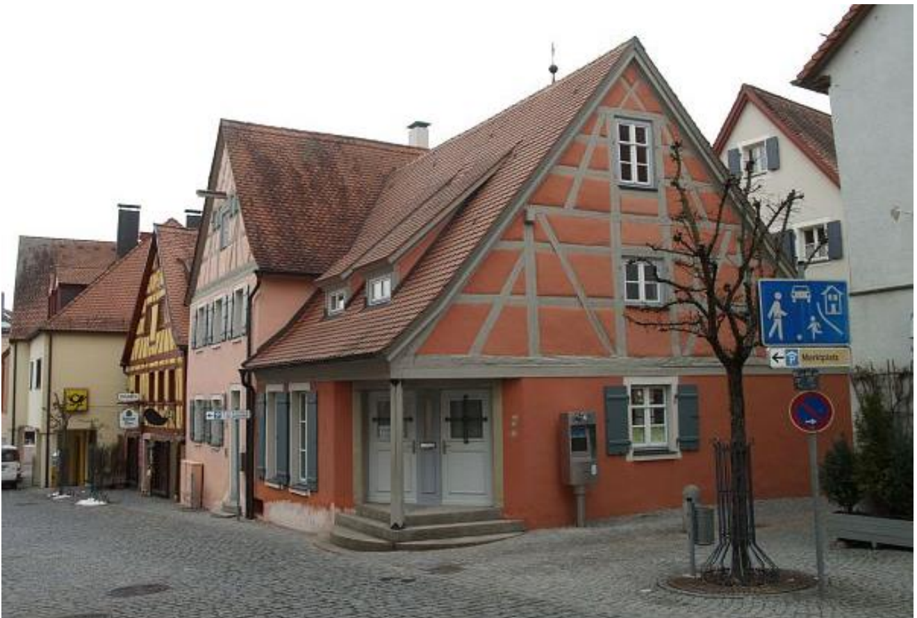
Das Gebäude der ehemaligen Mikwe in Gunzenhausen, März 2010 © Foto: Dr. Joachim Hahn
