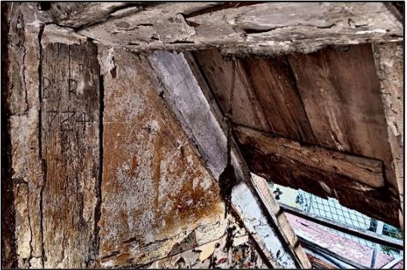
Auf dem Dachboden des Hauses von Samuel Eberhardt, das 2015 abgerissen wurde, befand sich eine spezielle Konstruktion, mit der Teile des Daches für das Laubhüttenfest geöffnet werden konnten. © Foto: Klaus Bub
