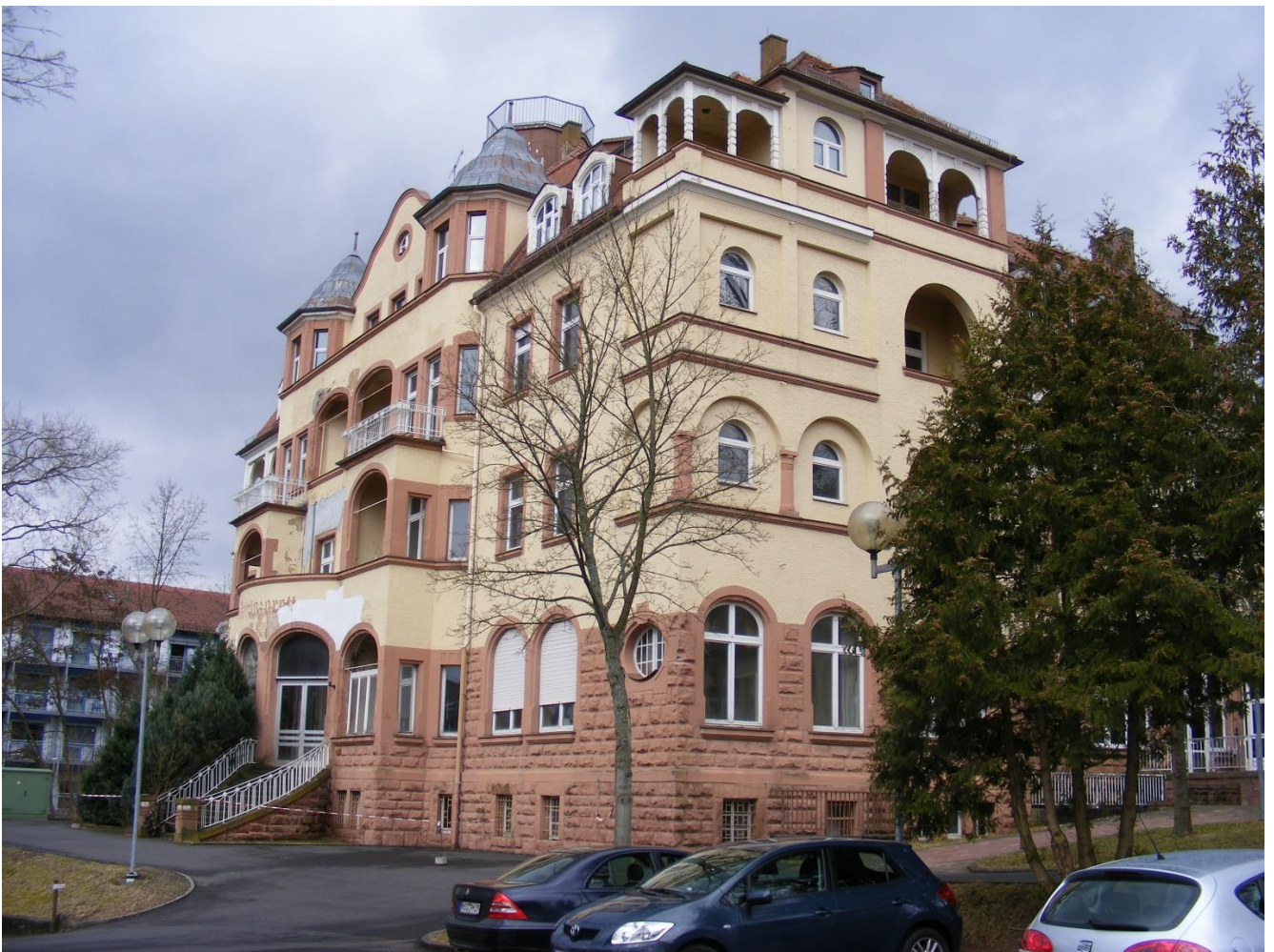
Ehem. Sanatorium Dr. Pick © Foto: Mattes; https://commons.wikimedia.org/wiki/File:Bad_Kissingen_-_Marinekurlazarett,_Außenansicht_seitl._re.JPG?uselang=de , Wikipedia, gemeinfrei, unverändert übernommen
