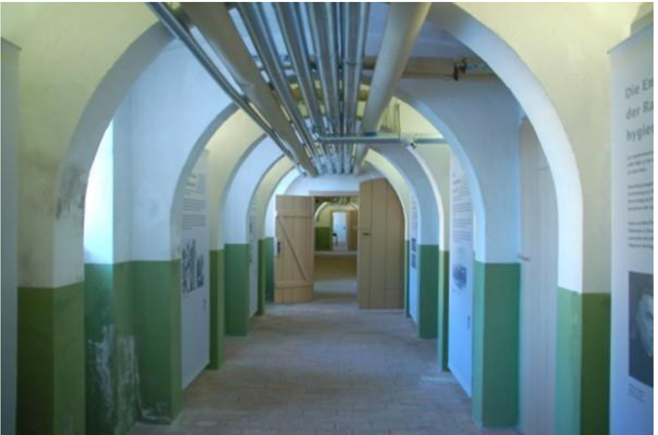
Treppe und Gang im Kellergeschoss © MDM Online/Sammlung der Gedenkstätte Bernburg
