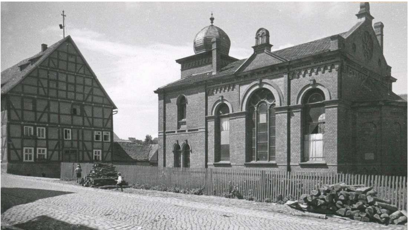
Die ehemalige Synagoge in Grebenstein, Straßenansicht © Archiv des Landesamtes für Denkmalpflege Hessen, Außenstelle Marburg
