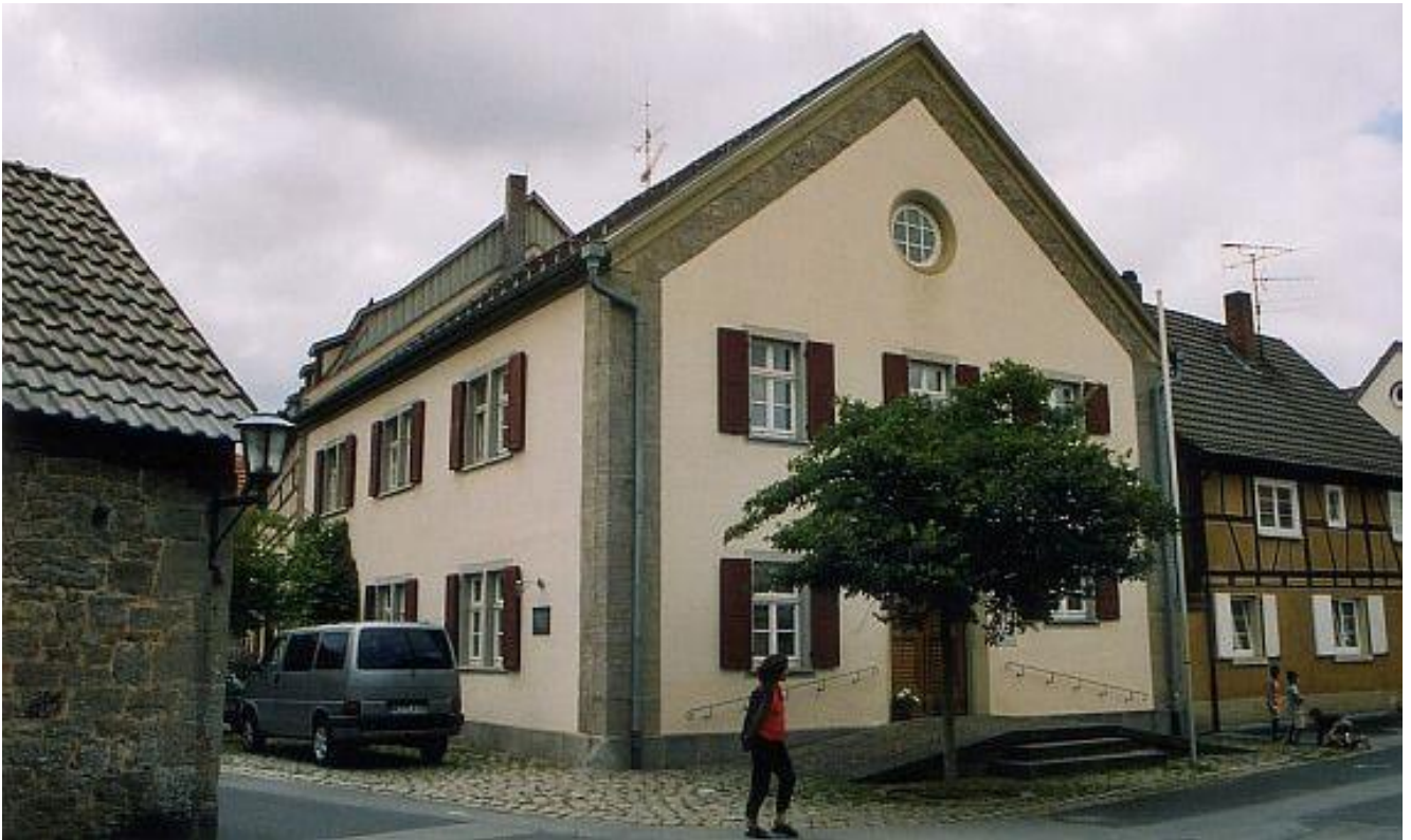
Das Gebäude der ehemaligen Synagoge von Unsleben, 2005 © Foto: Dr. Joachim Hahn
