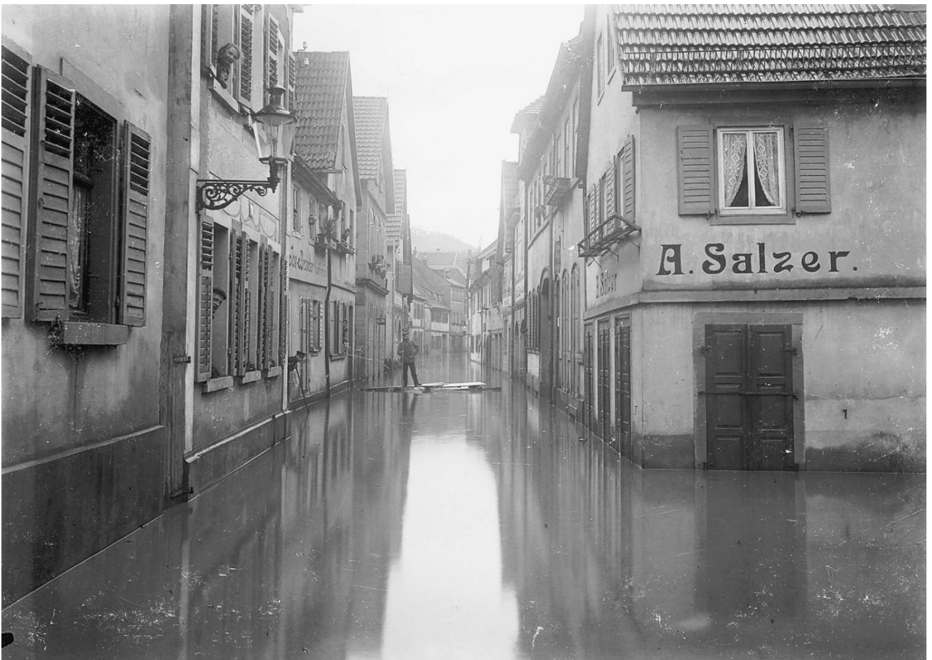
Das Haus Abraham Salzers in der Weidgasse während des Jahrhunderthochwassers 1909 Stadtarchiv Bad Kissingen. Fotosammlung
