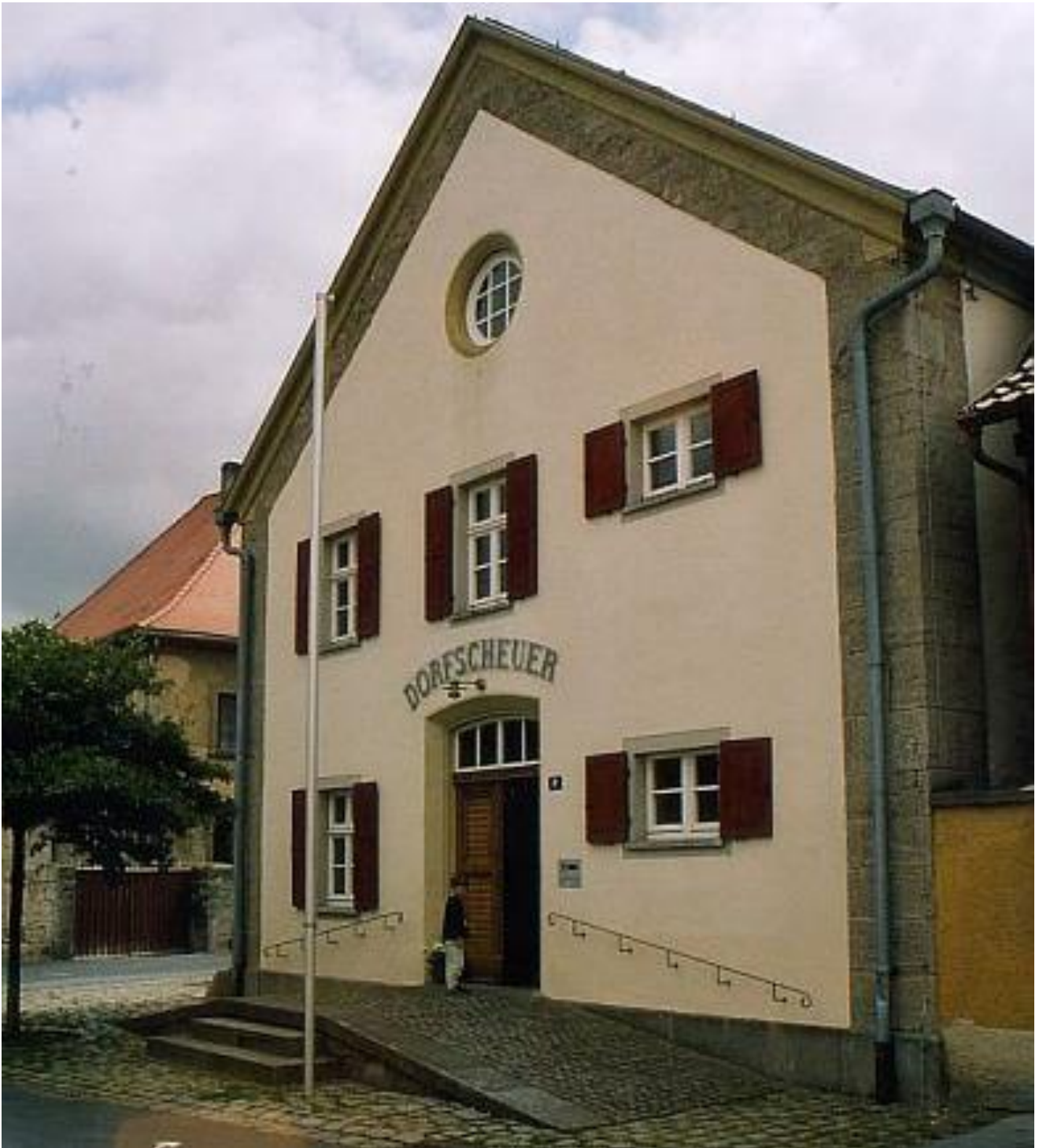
Das Gebäude der ehemaligen Synagoge von Unsleben, 2005 © Foto: Dr. Joachim Hahn
