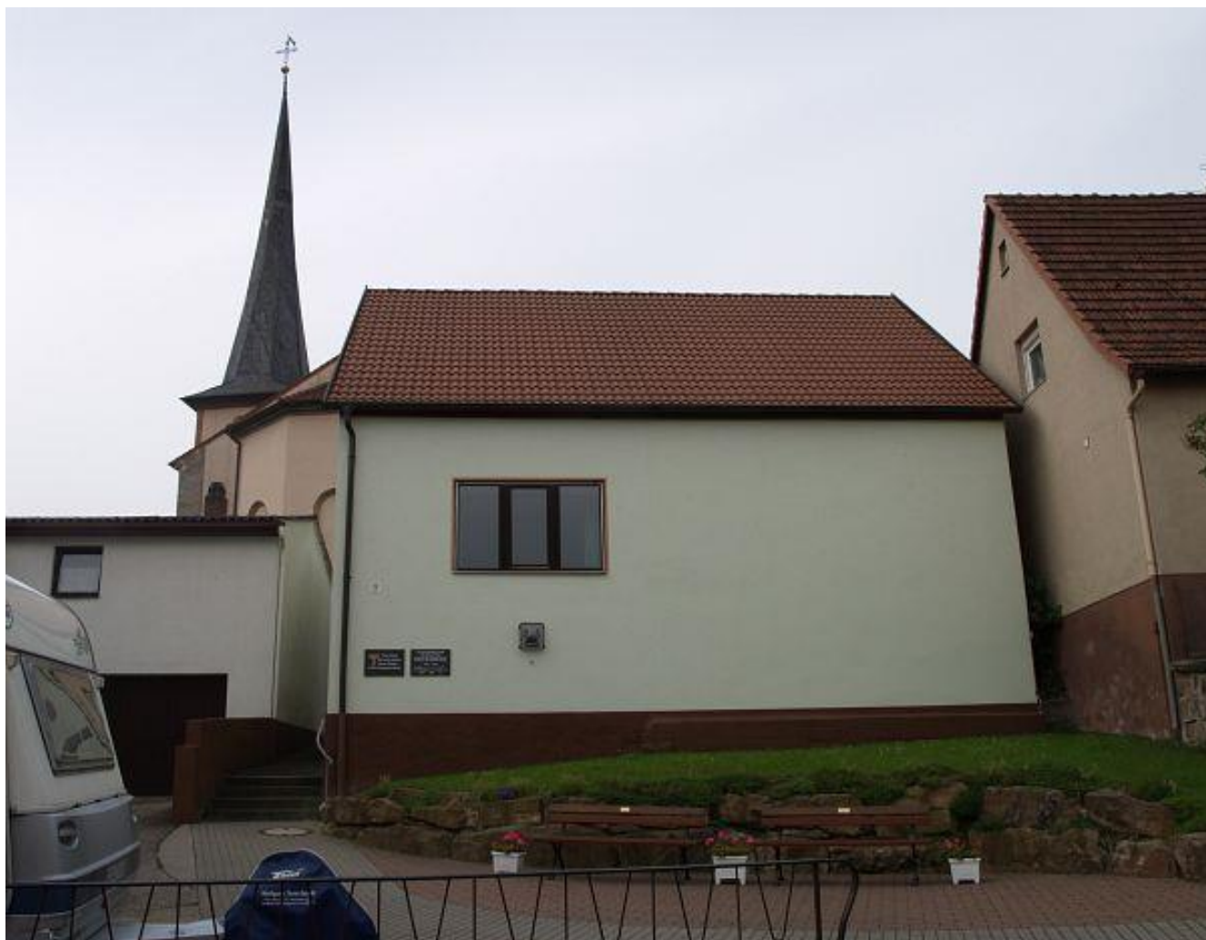
Das Gebäude der ehemaligen Synagoge in Obethulba im Frühjahr 2007 © Foto: Dr. Joachim Hahn
