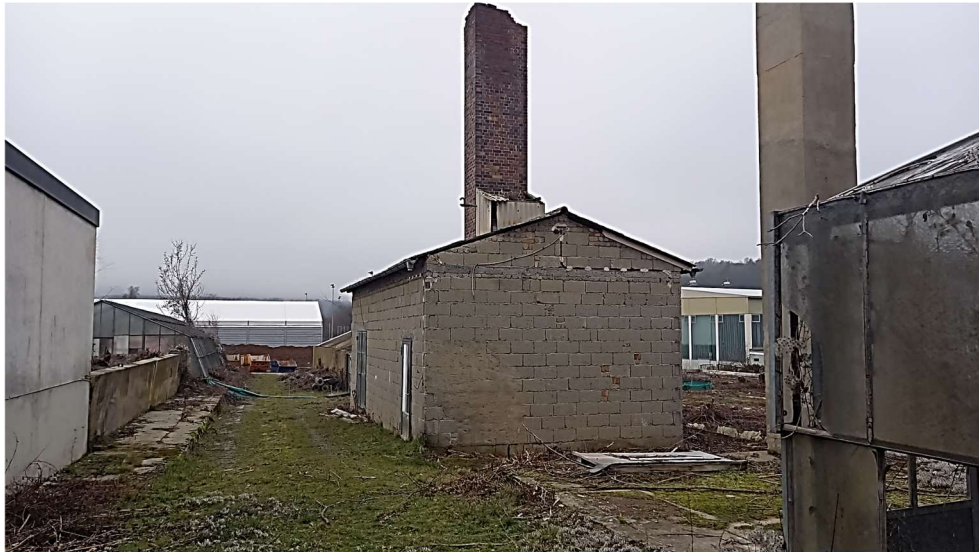
ehem. Nebengebäude (Heizung) im mittigen Grundstücksbereich des gepl. SO-Gebietes; Blick nach Süden
