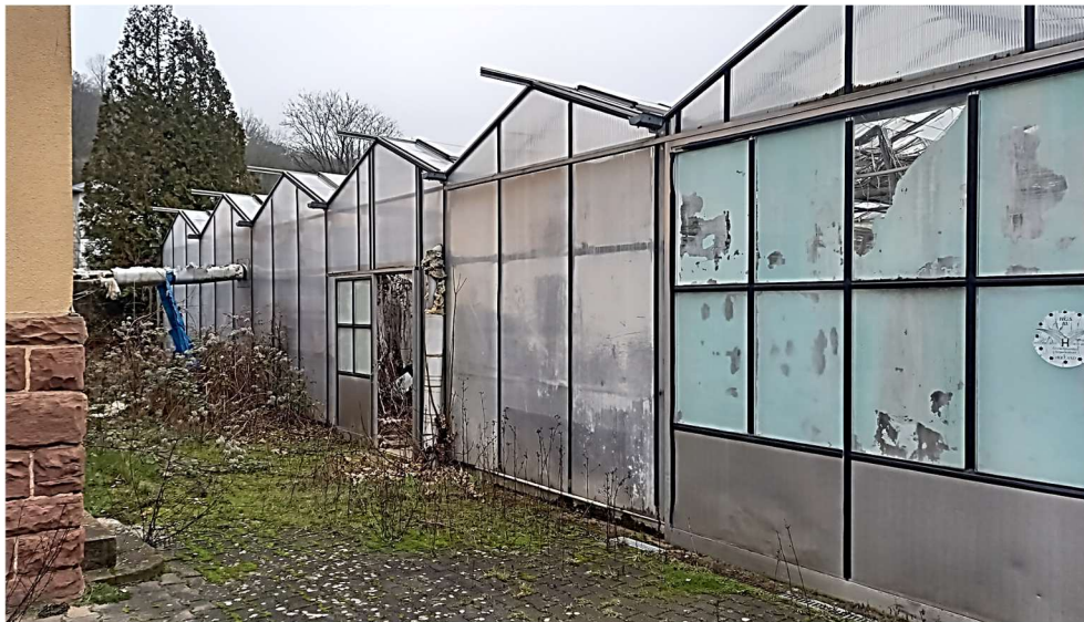
ehem. Gewächshäuser im rückwärtigen Bereich der Zaak-Villa; Blick nach Südosten
