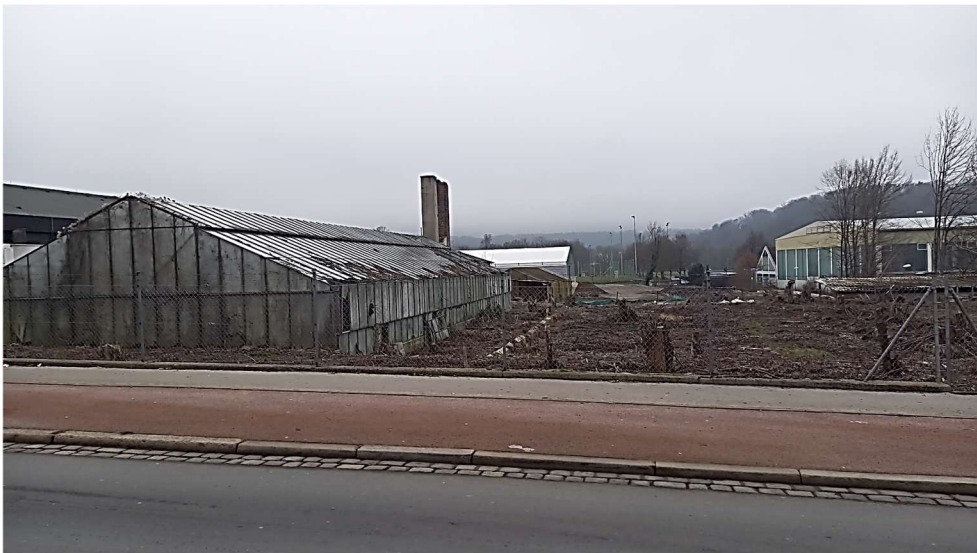
ehem. Gewächshaus an Oskar-von-Miller-Str. mit Rodungs-/Abbruchfläche; Blick nach Süden
