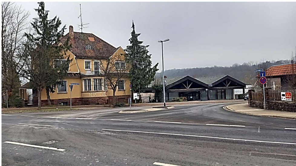
best. Einmündung Oskar-von-Miller-/Würzburger Straße (B286); B (St 2303); Blick auf Planfläche (Zaak-Villa und ehem. Verkaufsgebäude)
