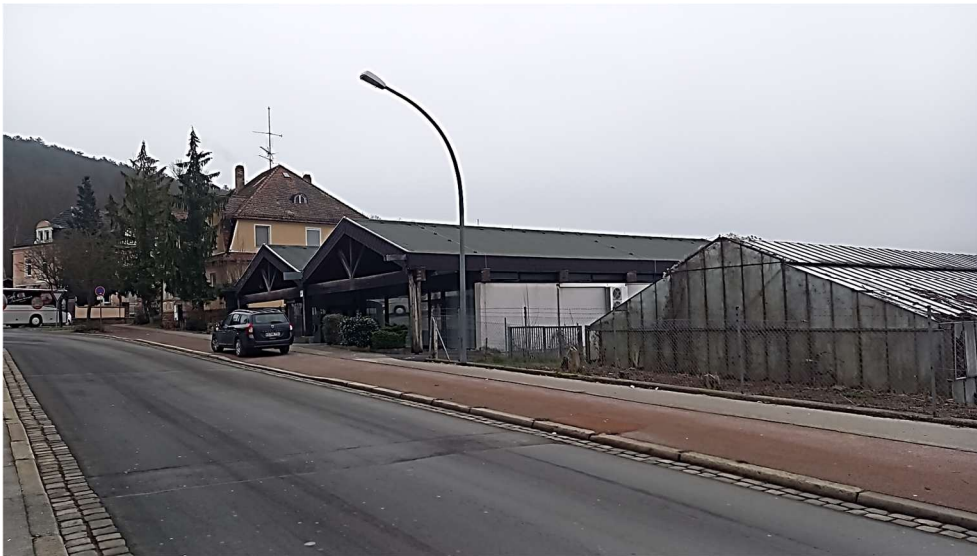
ehem. Verkaufsgebäude mit Gewächshaus an Oskar-von-Miller-Str.; Blick nach Südosten
