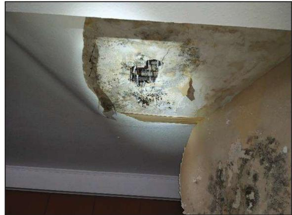
**Abb. 43:** Wasserschaden an der Decke des ersten Stocks
