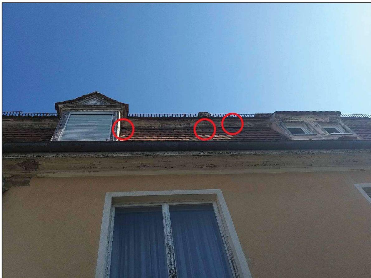
**Abb. 13:** Spalten an der südlichen Dachseite der Villa
