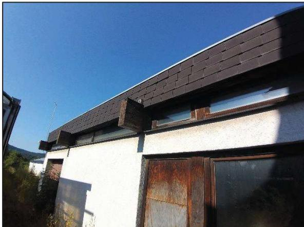
Abb. 34: Dachkantenverschalung (Ostseite)
