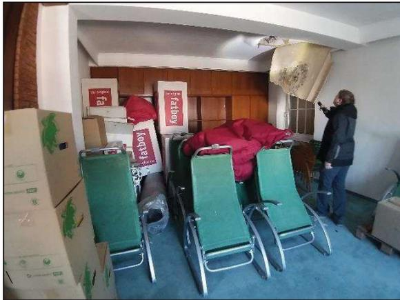
**Abb. 42:** Wasserschaden an der Decke des ersten Stocks
