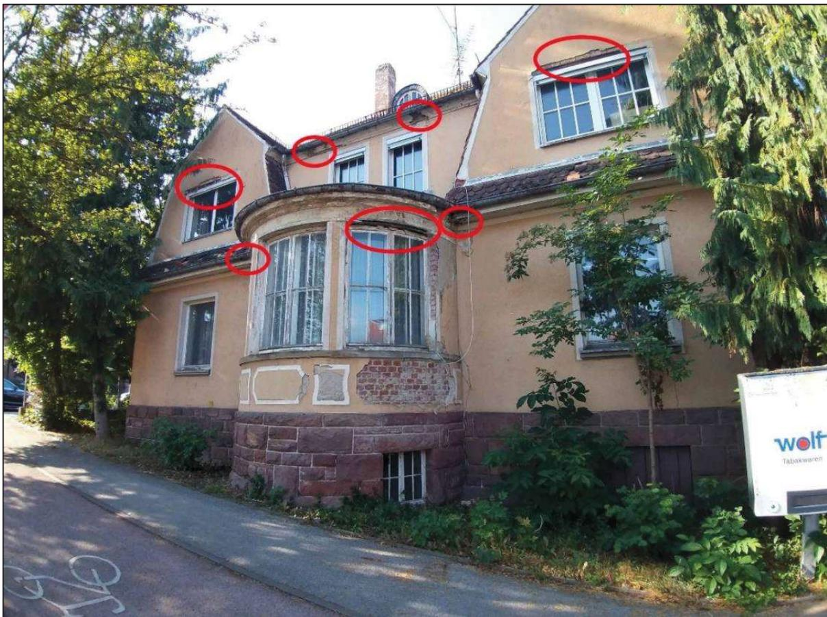
**Abb. 12:** Spalten und Risse an der nördlichen Fassade der Villa
