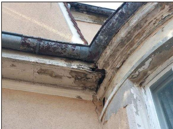
Abb. 48: Spalte (nördliche Seite der Fassade)
