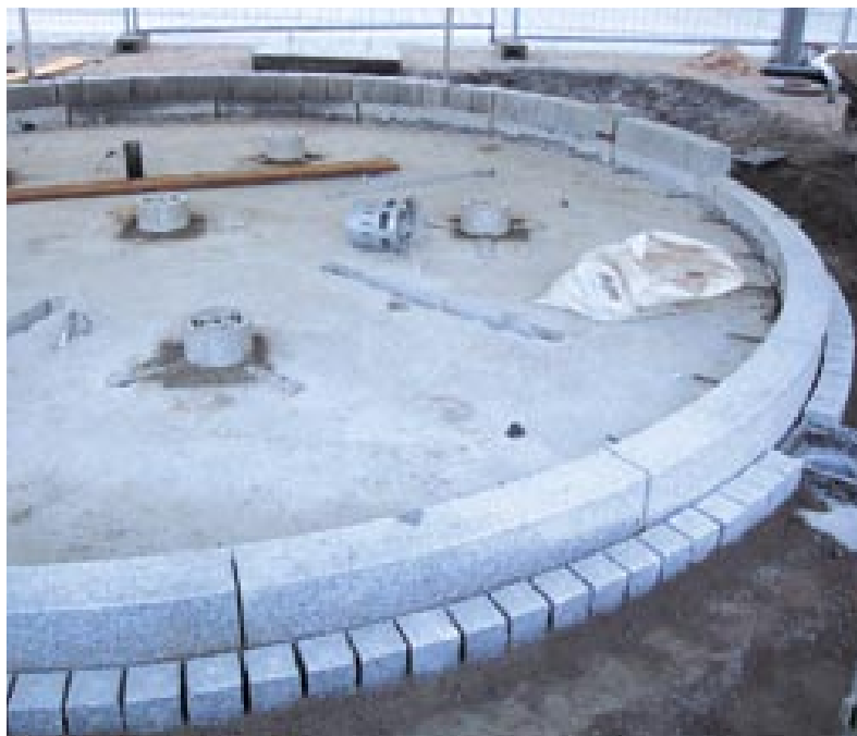
Montage der Wasserdüsen für das Wasserspiel im Brunnen
