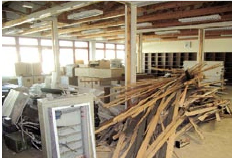
Erst mal alles raus: Die Bauarbeiten in der ehemaligen US-Schule haben begonnen
