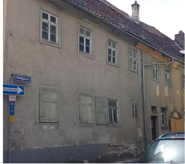
Abb. 51: Beispiel eines leerstehenden und modernisierungsbedürftigen Wohnhauses in der Altstadt Bad Kissingen
